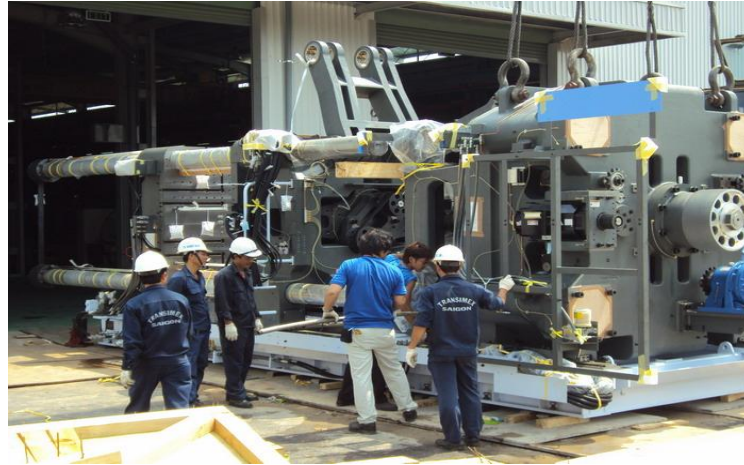
Hình 3: Vận chuyển, di dời, lắp đặt tại KCN Biên Hòa I, máy ép nhựa JSW 1300, trọng lượng 110 tấn
